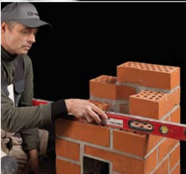
Hormin muuraus on nopeaa harkkotiilellä.
